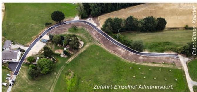
**Zufahrt Einzelhof (Allmannsdorf 36-38):** Es wurde die Verkehrsfläche mit Nebenanlagen auf einer Baulänge von ca. 255 m saniert. Die Erschließungsstraße verfügt nun über eine Breite von 3,00 m, an die sich beidseitig ein Bankett von 0,75 m anschließt.
